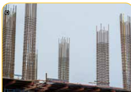
ESTRUTURA DE AÇO PARA A CONSTRUÇÃO DE UM PRÉDIO.
